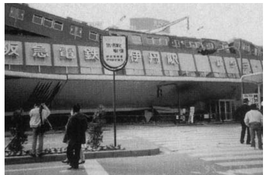
大震災 阪急伊丹駅 崩壊
